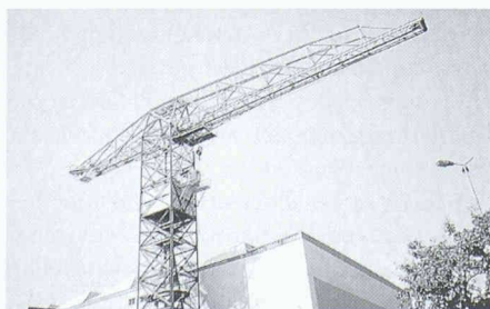
Containerkran, Europort, Rotterdam
