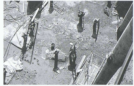
Grossbaustelle Potsdamer Platz (Bild: H. Gadiant)
