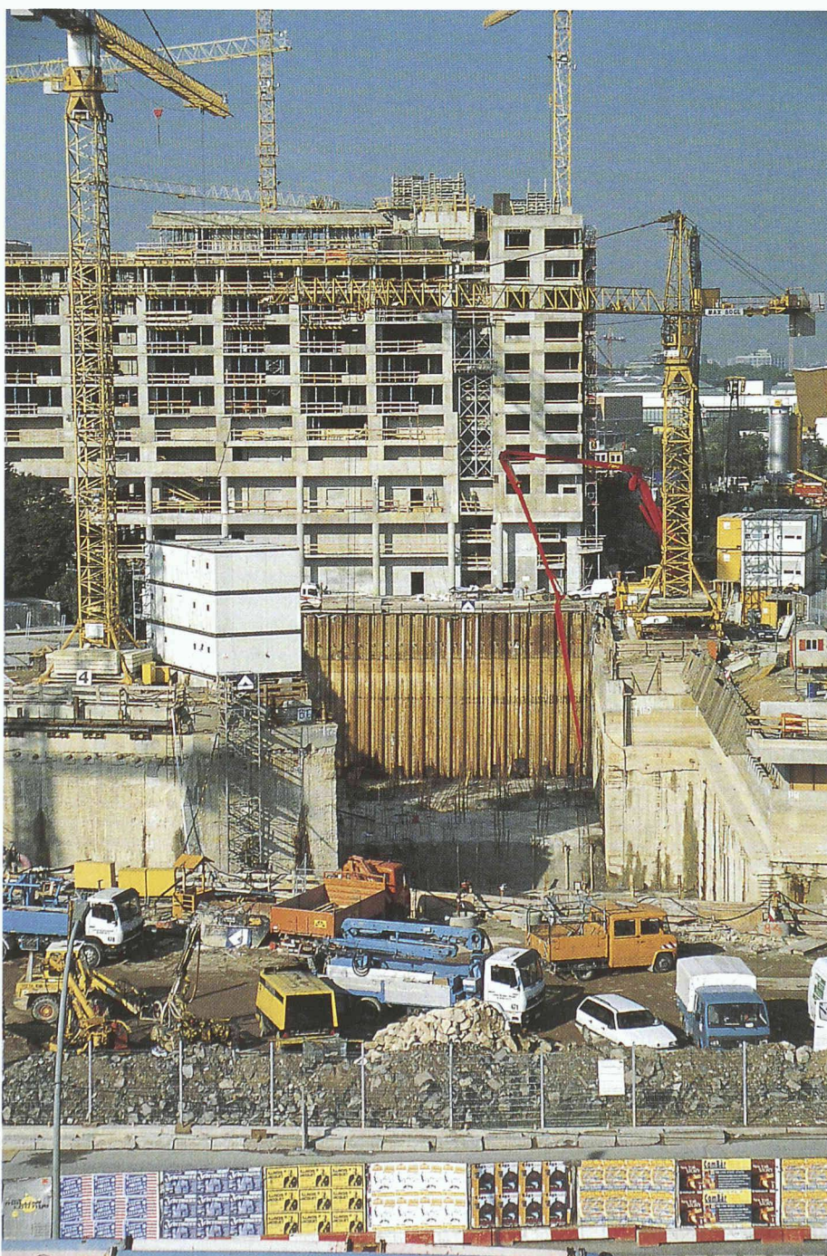
Grossbaustelle Potsdamer Platz, Berlin (Bild: H. Gadiant)
