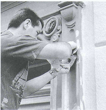
Die Restaurierung schützenswerter Bauten schafft hochwertige Arbeitsplätze (Bild: SHS)
