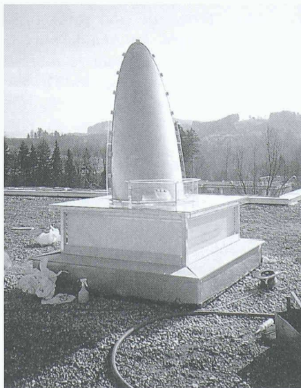
Die Signer Ingenieurunternehmen AG erhielt für ihren Tageslichtleiter Heliobus den M.U.T.-Umweltpreis 97. Das Bild zeigt den Reflektor der Pilotanlage Schulhaus Boppardshof in St. Gallen
