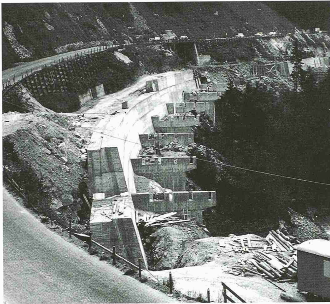
2 Verlegung Kantonsstrasse Wassnerwald. Von links: Prov. Kantonsstrasse, best. Kantonsstrasse als Bauzufahrt, talseitige Stützmauer der projekt. Autobahn, Pfeiler der neuen Kantonsstrasse, Viadukt Wassnerwald
