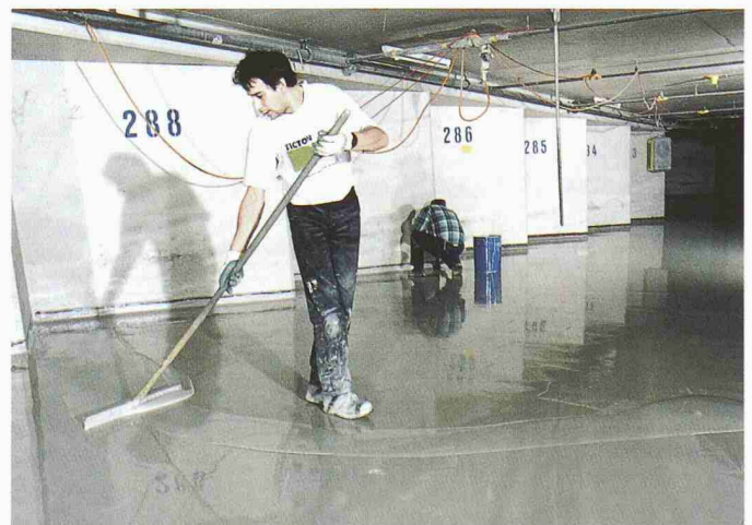
Applikation des Parkbelagsystems (Bild: F. Podolak, Wollerau)
