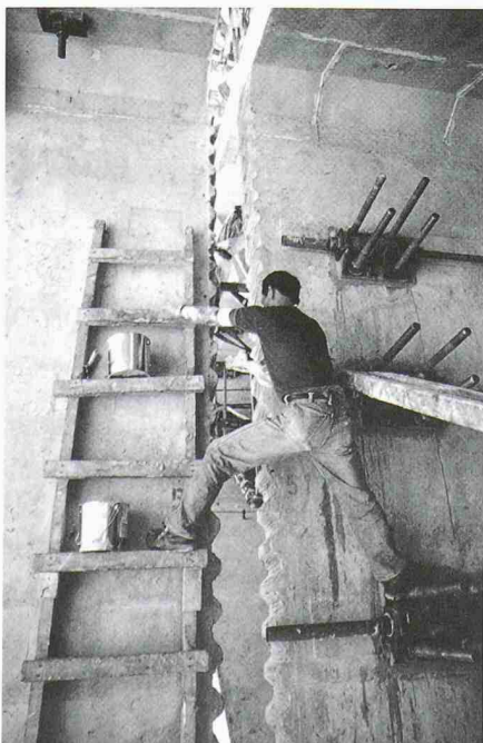
Aufbringen des Epoxidmörtels in der Segmentfuge
