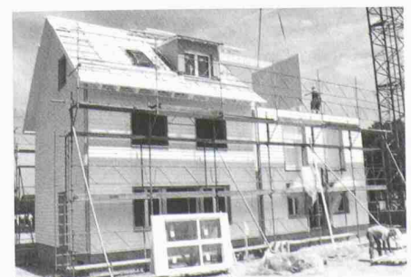
5 Noah-Haus nach Minergie-Standard, Pilotanlage 1 «Grafstal», Kanton Zürich (Alfredo Piatti AG). Das Bild zeigt den Bau eines Holz-Leichtbaus in Grosstafelbauweise (Häring AG, Pratteln, BL). Eine Haushälfte wird in einem Tag auf dem vorbereiteten Fundament errichtet
