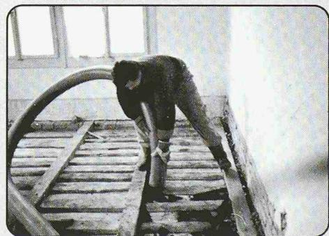
Absaugen von Zwischenböden bei Renovati-
