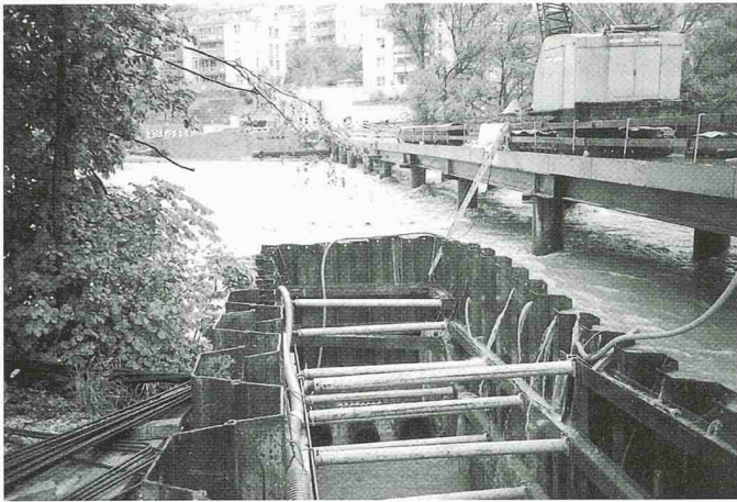
6 Hochwasser vom 12./13. Mai 1999
