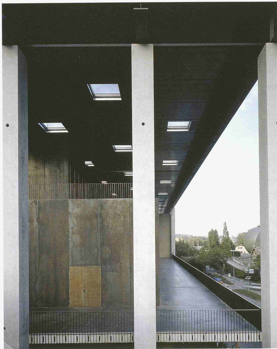
Blick zwischen der westlichen Stützenreihe auf die untere Terrasse. Sichtbar sind die Verkleidungen aus Cortenstahl, sichtbar auch die Dimensionen (Bild: Eduard Hueber, New York)
