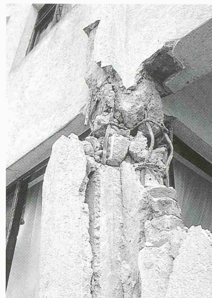
Konstruktionsdetail: Verbindung Stütze-Balken
