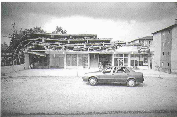
5 Komplettes Versagen eines Gebäudes («pancake»-Schaden)
