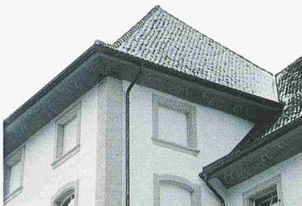
Dachuntersicht beim renovierten Konvent an der Südfassade
