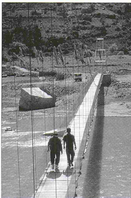
Die Brücke über den Río Paute in Ecuador hat eine Spannweite von 100 m
