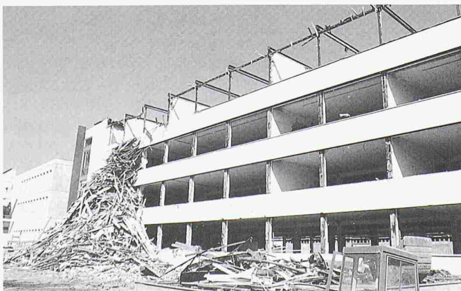
Das ehemalige Berufsschulhaus: das später aufgesetzte vierte Geschoss ist demontiert. Vorne Metallhaufen, hinten Altholzberg
