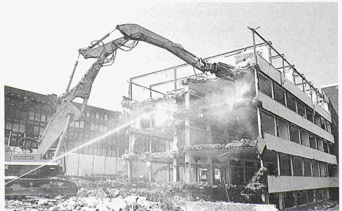
Abbruch der Betonkonstruktion
