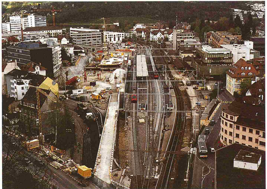
Bauboom in Baden. Links der Geleise entsteht ein 150 Meter langes Wohn-, Büro- und Ladengebäude; die Bahnanlagen werden ausgebaut, neue Bushöfe kommen hinzu (Bild: Alex Spichale)
