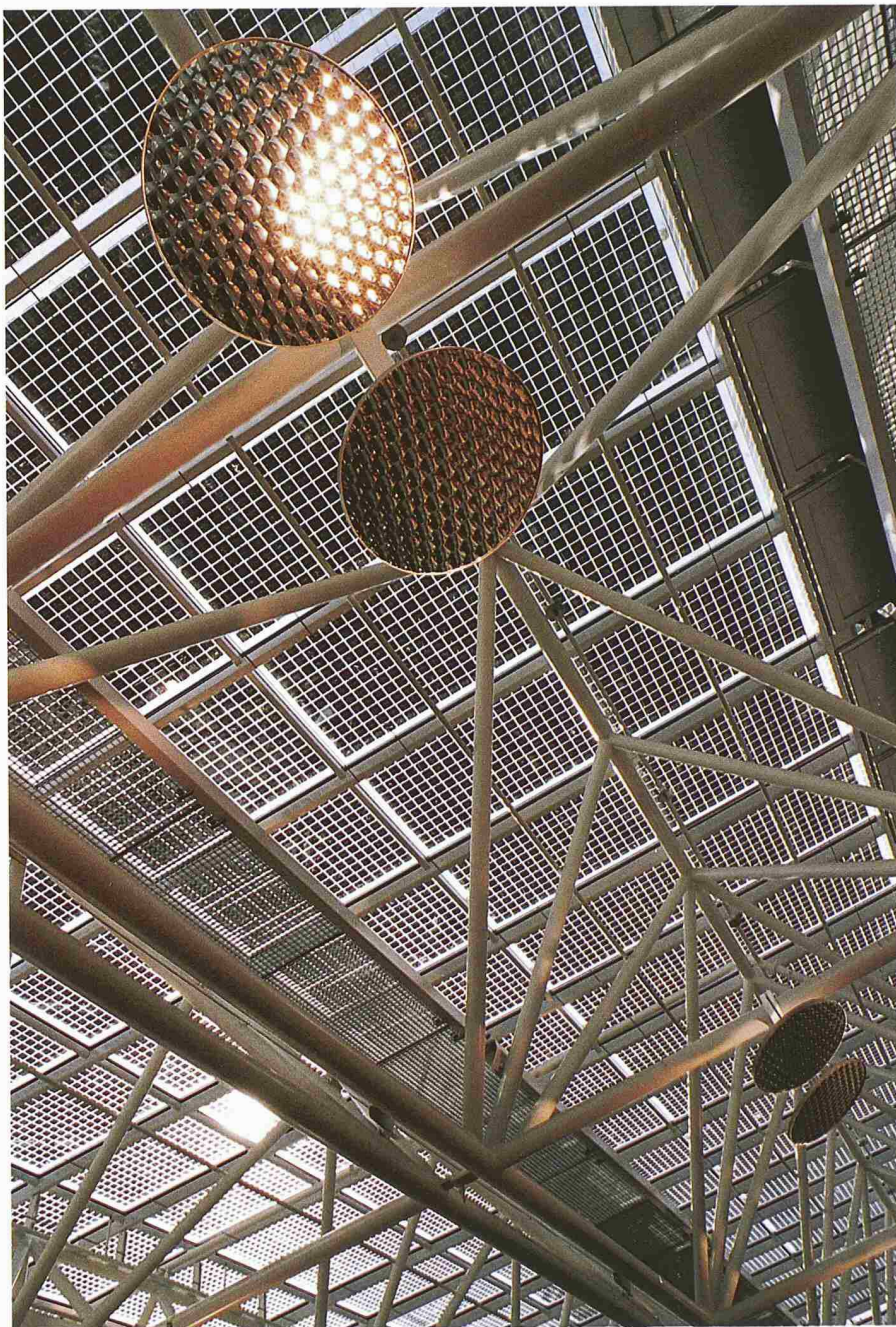
Migros Limmatplatz, Zürich 1999. Dachintegrierte 31 kWp-Anlage mit Photovoltaik-Isolierglas-Modulen. Planung: Energiebüro Zürich (Bild: Energiebüro Zürich)
