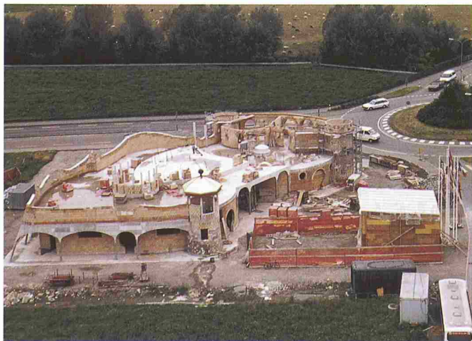
Markthalle Hundertwasser in Altenrhein
