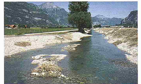
3.1, 3.2, 3.3 Giessen: vorher (links) – Bau (rechts) – nachher (oben)
