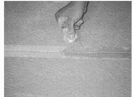
3 Einpressen der Lamelle in den mit Epoxidkleber verfüllten Schlitz
