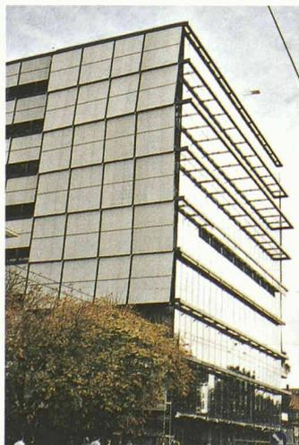
**Neubau Hoffmann-La Roche, Basel (Laborbau 92). Autonom formbare Gebäudehülle durch textilen Sonnenschutz. Spezialbeschattungen, ausgerüstet mit alubedampftem Gittergewebe. Idee und Gestaltung sind eine Schöpfung von Herzog & de Meuron Architekten AG, Basel; sie wurden von Kästli Storen, Bern umgesetzt**
