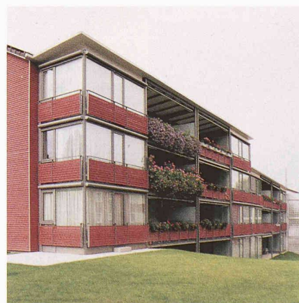
Anerkennung für Anne-Marie Fischer und Reto Visini für die Genossenschaft «Waidmatt» an der Wehntalerstrasse in Zürich (s. auch tec21, H. 22, S. 46
