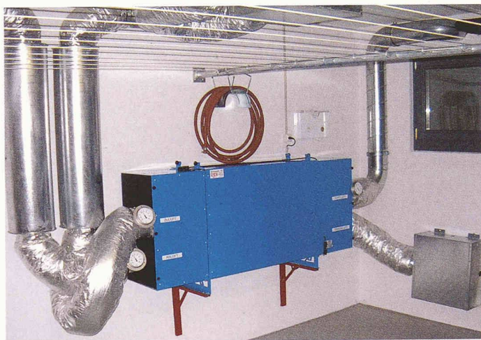
Im Wärmetauscher – der «Lunge» von Komfortlüftungen – werden rund drei Viertel der Abluftwärme zurückgewonnen und an die Frischluft abgegeben, die in die Räume geblasen wird (Bild: Thomas Glatthard)
