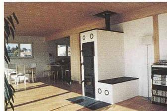
werden auf den Wärmebedarf des Hauses ausgelegt und entsprechend dem Hausgrundriss gestaltet, für einfache Fälle steht ein preisgünstiger Kleinspeicherofentyp zur Verfügung. Das System ist auch an bestehende Zentralheizungen anschliessbar, anstelle von Cheminées, Cheminéeöfen oder ersatzbedürftigen Heizkesseln.
