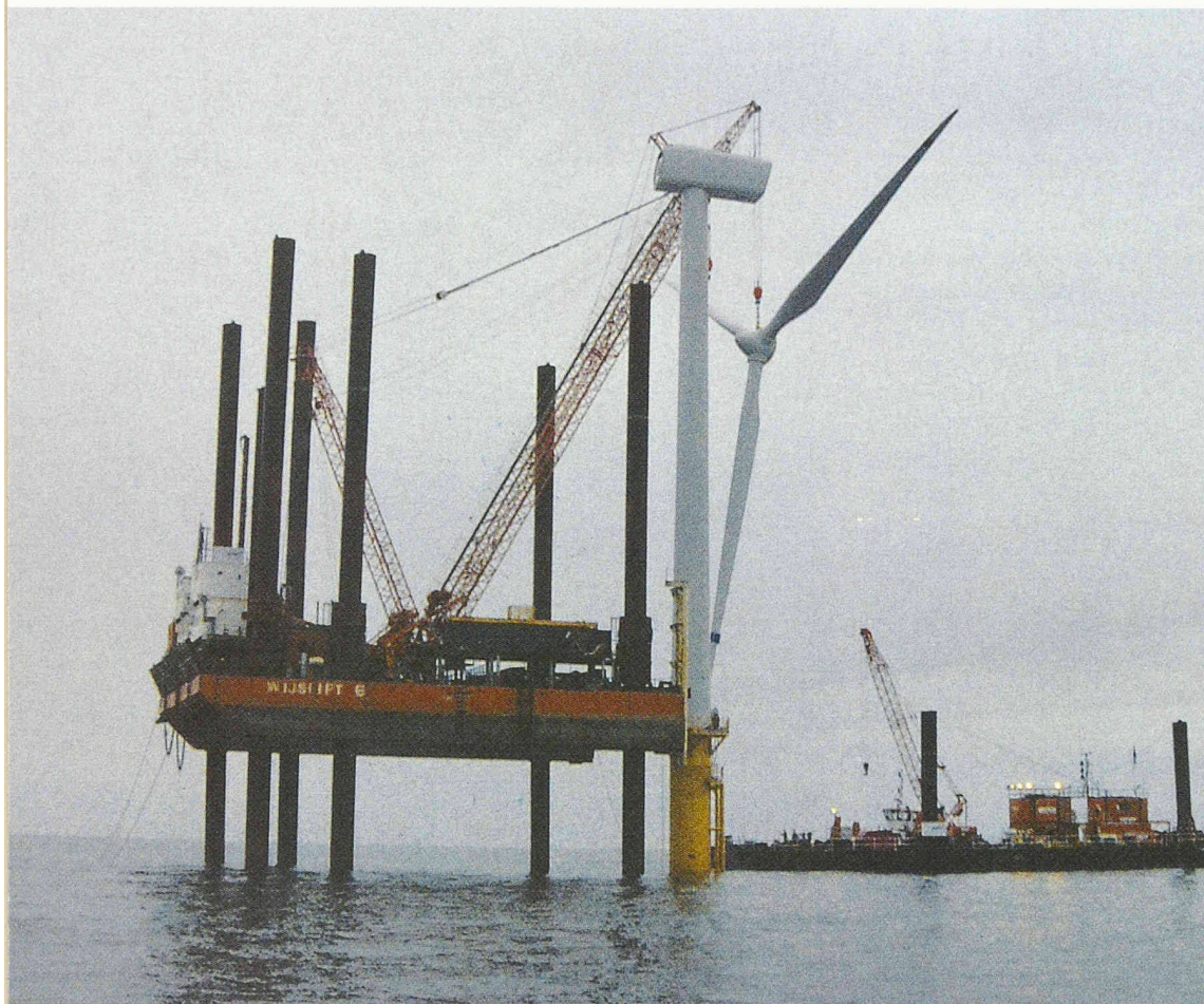
Heben des Rotors
