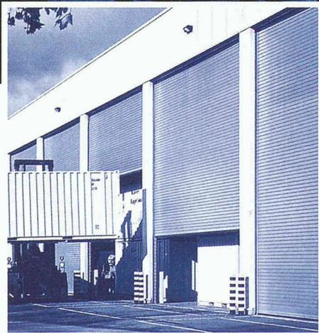
Hörmann Stahl-Sectionaltore mit E.-Antrieb und Steuerung
