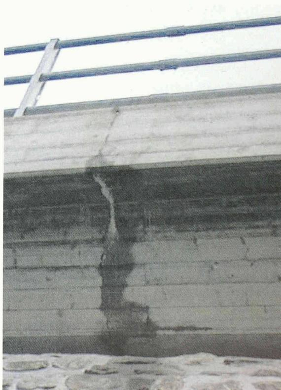
nichts, oder man beschränkt die Risse im Kordon mit konstruktiven Massnahmen. Und mit der aufwändigsten Lösung, die vor allem zur Anwendung kommt, wenn auch tragende Bauteile betroffen werden, verhindert man die Wassereindringung in diesem Bereich mit einer speziellen Abdichtung wie z.B. mit einer Beschichtung.
