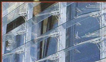
Das ganzflächig zu öffnende rahmenlose Doppelhaut-Fassadensystem senkt Ihre Gebäudeunterhaltskosten massiv. Ideal für Neubauten – optimal für Sanierungen.
