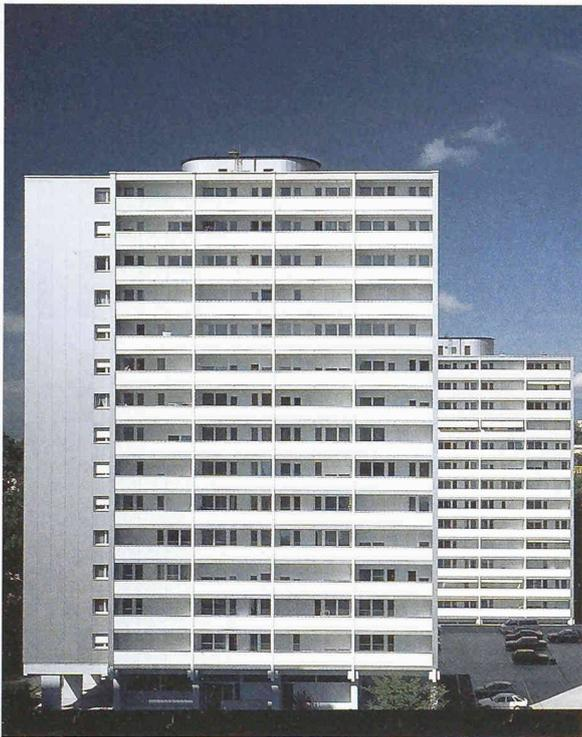
Die drei Hochhäuser «Parc de la Rouvraie» in Lausanne: saniert und mit rund 8500 m<sup>2</sup> Aluminiumplatten verkleidet (Bild: pd)
