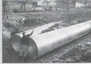
Montage eines HAMCO-Wellstahlrohres in Ermensee, Kt. Luzern.
