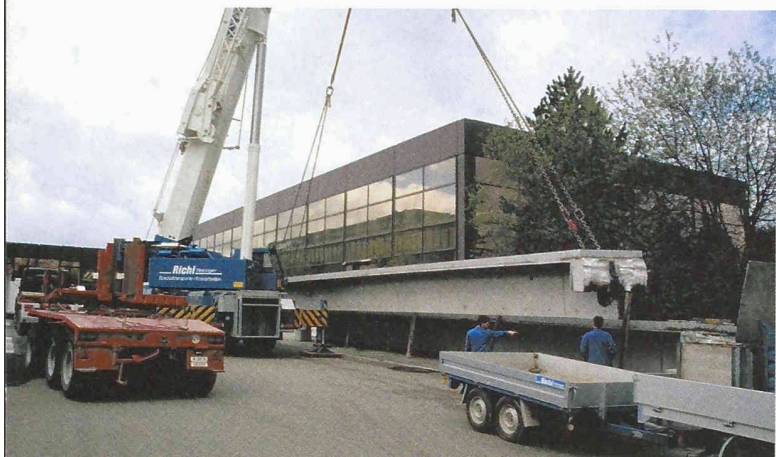
Umsetzen eines Trägers mit Autokran
