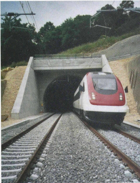
Ostportal des Tunnels «La Raisse»
