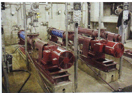
Kaltschlammumpen fördern den Schlamm zu den Wärmetauschern
