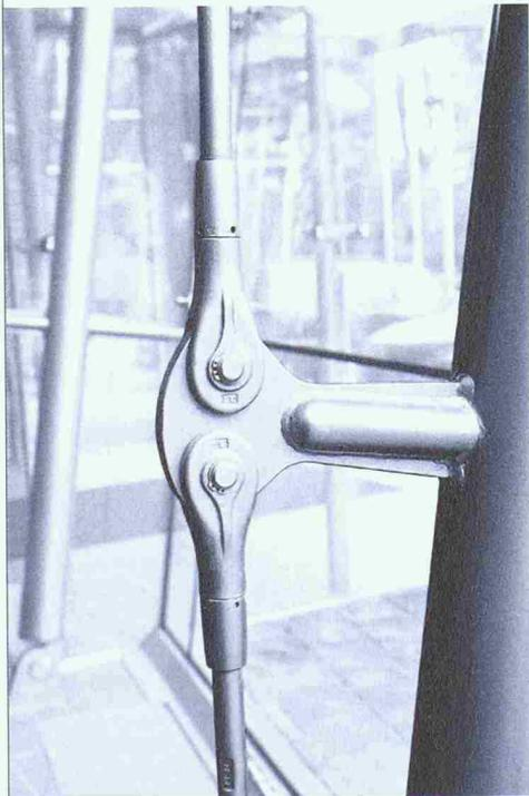
Der Name DETAN steht für unser Zugstabsystem, das in jeder Hinsicht in Form und Funktion überzeugt. Es ist in fünfzehn Stabdurchmessern von 6 bis 60 mm erhältlich.
