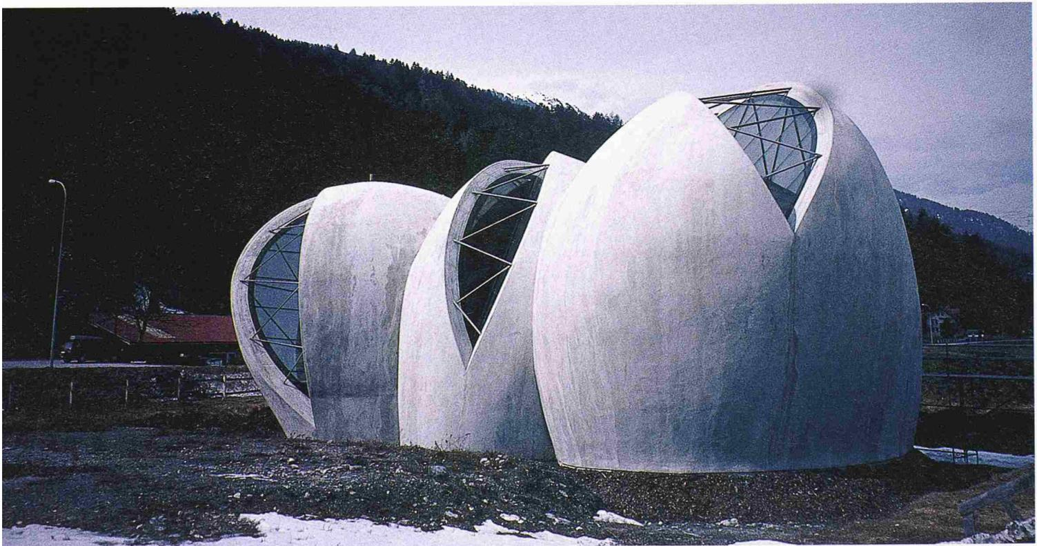
hallen sowie die Überdachung von Tankstellen. Die Konstruktionsprinzipien finden auch Anwendung für Kirchenbauten wie in Lommiswil bei Solothurn 1967 und Cazis GR 1996 (Bild 7) sowie bei Ballonschalen-Wohnhäusern (Kugelhäuser) bei Paris und Stuttgart.
