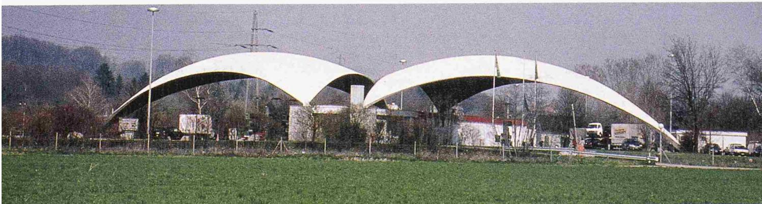
innen unter Druck. Mit dieser Methode kommt Isler 1954 zu den so genannten *pneumatischen Formen* und beginnt, Buckelschalen zu konstruieren (Bild 1).
