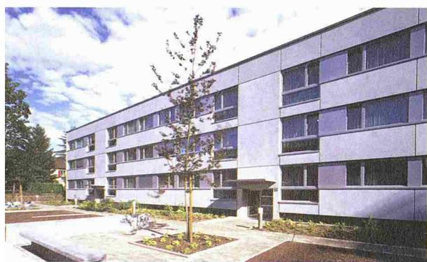
Alle ehemals hellgrauen Kittfugen wurden neu schwarz eingebracht, um das Bild der Elementbauweise noch zu verstärken. Der positive Nebeneffekt dieser dunklen Fugen ist, dass eine erneute Verschmutzung nicht mehr sichtbar sein wird. Mit dem Ersetzen der weiss gestrichenen Holzfenster durch dunkelgraue Metallfenster entstand ein starker Kontrast zu den hellen Betonplatten. Wenn bei Tageslicht die Fensterbänder dunkel erscheinen, wird so die horizontale Schichtung des Fassadenbildes hervorgehoben.
