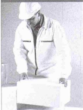
Durch Griffaschen und das geringe Gewicht ist der PORIT Stein besonders handlich, lässt sich leicht heben und versetzen. PORIT hat ein Doppel-Nut und Feder-Profil. Die Steine können passgenau versetzt werden. Sie sparen sich die Stossfugenvermörtelung und damit Zeit. PORIT ist massiv, kann jedoch leicht gesägt und bearbeitet werden. Leitungsschlitze werden gefräst, Schalteredosen gebohrt.
