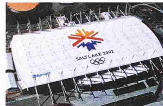
Verwendung von beinahe 2 Hektaren weisser Sarnafil-Abdichtungsmembrane werden sehr gute Werte bezüglich Temperaturregulierung erreicht. Sarnafil bietet weltweit qualitativ hochwertige Dachsysteme. Die Produkte erfüllen die höchsten Anforderungen, die an eine Dichtungsbahn hinsichtlich Dimensionsstabilität, Dehnfähigkeit, Flexibilität, mechanischen Widerstand, chemische Resistenz und Langlebigkeit gestellt werden. Sarnafil AG
