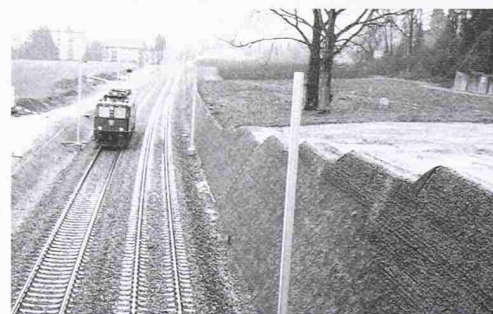
60° Steilböschung neue Doppelspur MThB Kreuzlingen.
