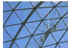
Atriumdach der DG-Bank, Berlin; Arch.: Frank O. Gehry, Santa Monica; Innenansicht, Speichenrad, Dreiecksmasche
