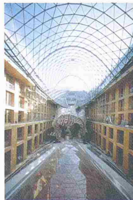
Atriumdach der DG-Bank, Berlin; Arch.: Frank O. Gehry, Santa Monica; Innenansicht, Speichenrad, Dreiecksmasche
