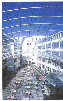
Innenhofüberdachung im ehemaligen Bosch-Areal, Stuttgart; Netzkuppel als Translationsfläche mit ebenen Maschen Arch.: Prof. Ostertag, Stuttgart
