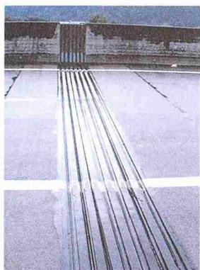
Oberes Bild: Neuer Fahrbahnübergang Tensa-Flexfinger, SEEZ-Viadukt
