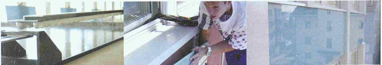
Verdeckte und wirtschaftliche Montage der Glas-Fassadenplatten durch Verkleben eines Einhängesystems in der Vorfabrikation mit SikaTack-Panel.
