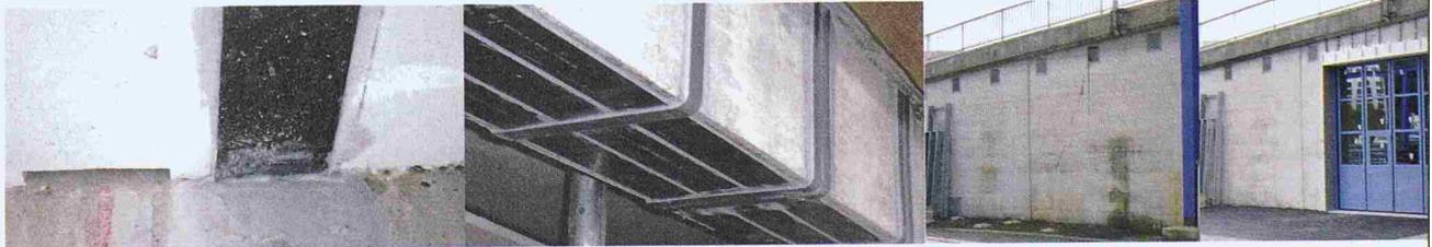
Biegeverstärkungen an Deckenuntersicht und neuem Torsturz mit CFK-Lamellen
