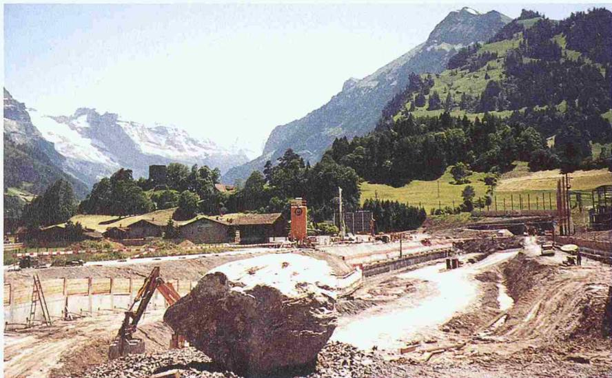
**Bau der offenen Interventionsstelle bei Frutigen. Bei Unfällen erleichtert die in einem offenen Graben anstatt durchgehend im Tunnel geführte Strecke den Zugang zur Unfallstelle (Bilder: Zoppet)**
