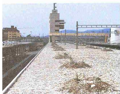
Reliefartige Dachbegrünung im HB Zürich
