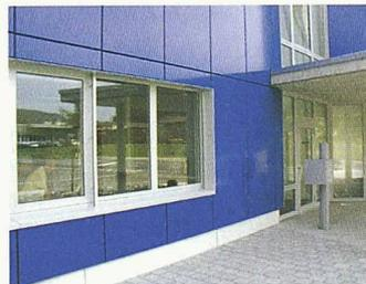
an der Fassade – auf Fassadenplatten und deren Formate abgestimmt – positioniert, dann die werkseitig vorgefertigten Fassadenplatten vor Ort in die Halterkonsole eingehängt. Diese rasche und sichere Montagetechnik basiert auf einem speziellen Einklinkverschluss zwischen Fassadenplatte und Plattenhalter und erlaubt zudem ein bequemes und genaues Justieren. Fassadenunterkonstruktion
