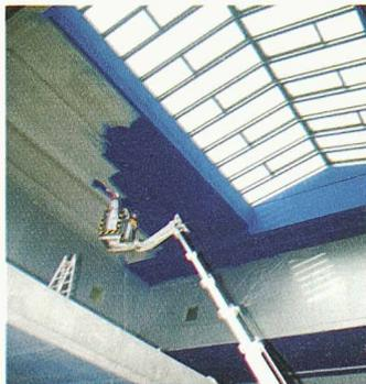
der Pizzeria im mediterranen Licht bis zur italienischen Espresso-Bar. Der Bauherr entschied sich bei der Wahl des Malerbetriebes für die Firma Harzenmoser AG. Die über 20 000 m<sup>2</sup> grosse zu bemalende Betonfläche erforderte den Einsatz von bis zu zehn Maler-Spezialisten am Bau. Der eingepflanzte Metalleffekt-Lack und die bunten Betonlasuren verlangten Know-how und Spezial-Maschinen wie Airlessgeräte oder Hebe-
