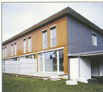
Minergie- und Passivhausbauweise
