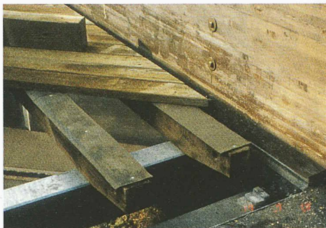
9 Trennschichten, um Feuchte- schäden zu verhindern
