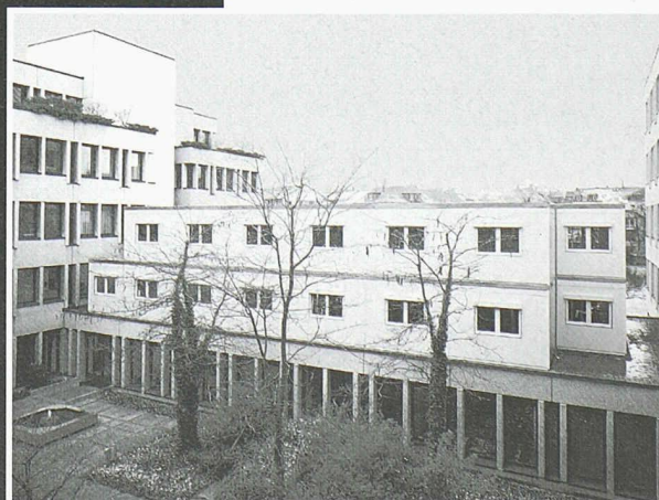
2-geschossiger Aufbau auf bestehendes Flachdach
